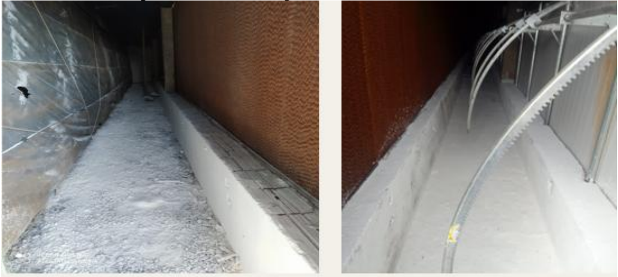
Figura 4 – Dog house (câmara de entrada de ar equipada com placas evaporativas para climatização) de um aviário de uma integradora localizada na região noroeste do estado do Paraná, 2025.
